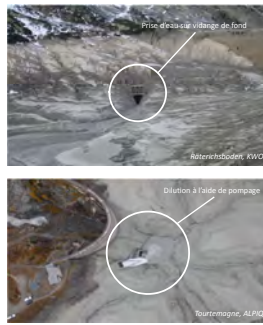
Figure 1: Ouvrages annexes et sédimentation observés lors de l'abaissement du niveau de l'eau
